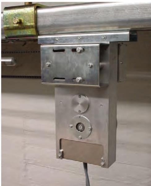
Il **DICTAMAT 5700** è una motorizzazione Dictator specifica per porte e portoni scorrevoli antincendio dotati di c/peso, a una o due ante a chiusura centrale.
